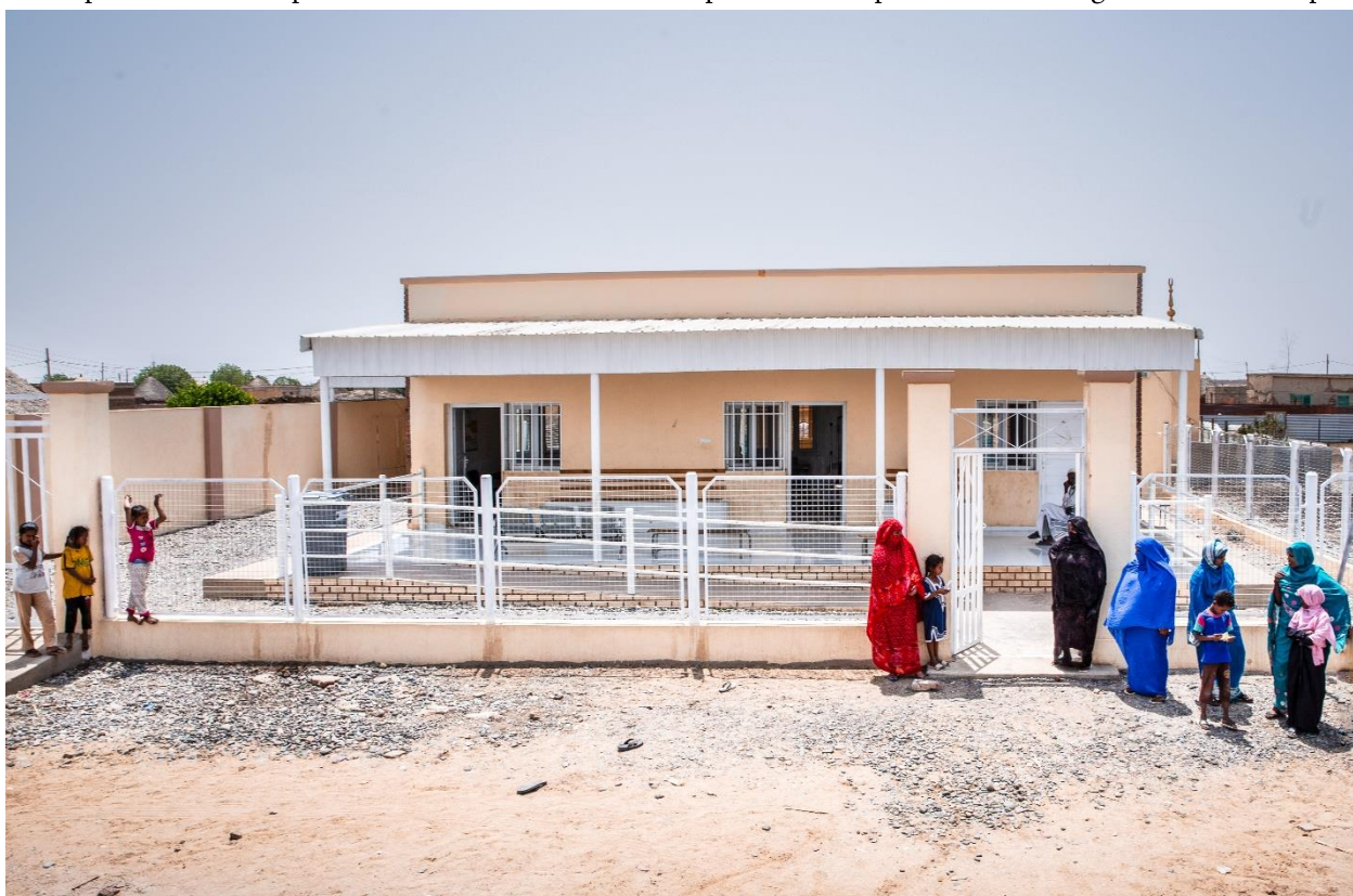
Figura 11. Dar El Salam Health Unit, Stato di Kassala
