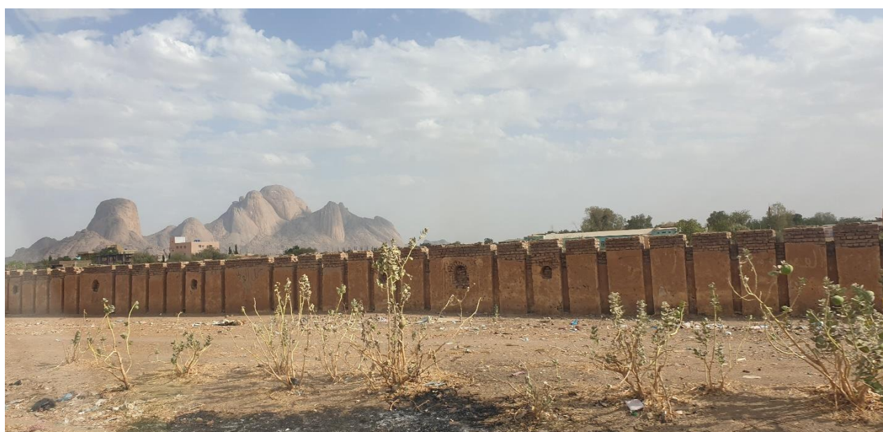
Figura 13. Muro di recinzione della Kassala Health Citadel. Sullo sfondo il monte Taka
