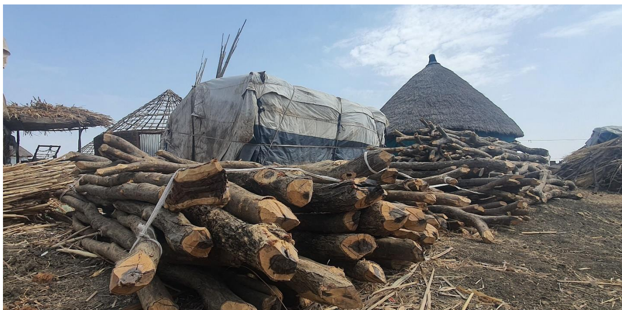
Figura 7. Tukul in costruzione nel campo rifugiati di Teneitba, Stato di Gedaref
