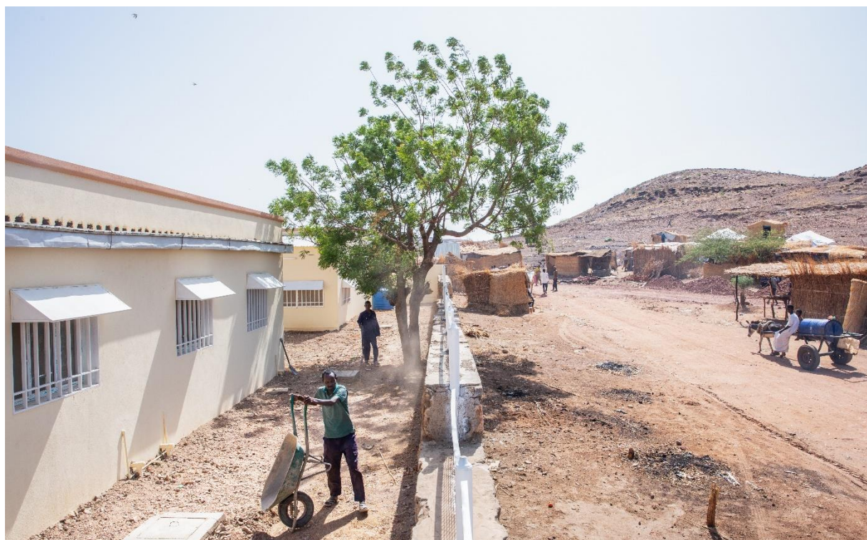
Figura 14. Riabilitazione dell'unico centro di salute in muratura del campo rifugiati di Umm Rakooba (Stato di Gedaref). Foto di Cinzia Canneri
