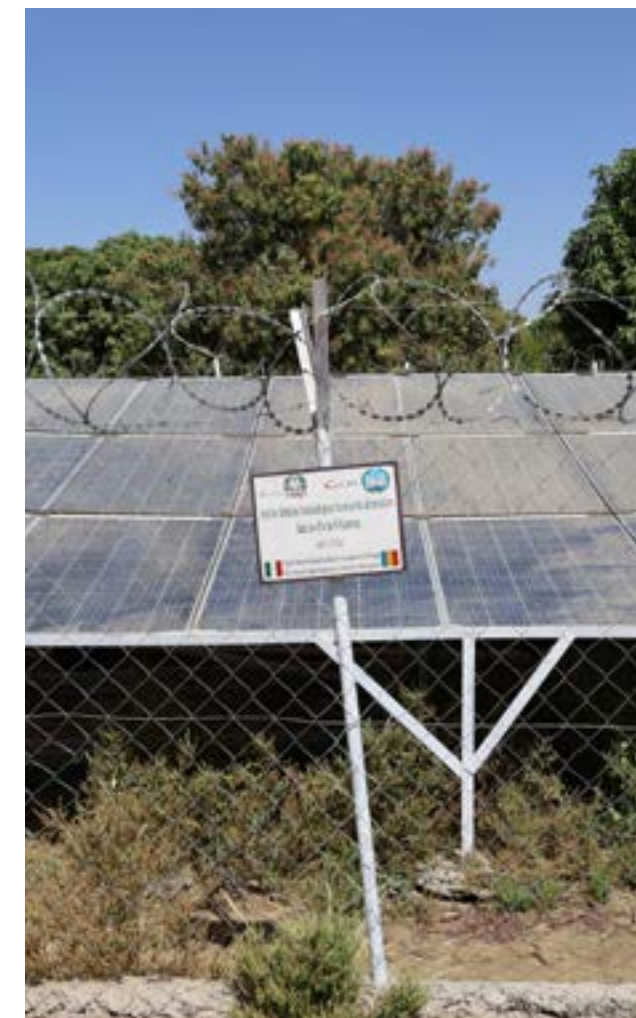
Figura N.51 - Intervento della OSC ACRA in Ciad / Pozzo ad energia solare realizzato nel sito di Amnabak.
